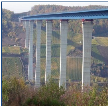
The mighty Hochmoselbrücke from high on the Himmelreich
